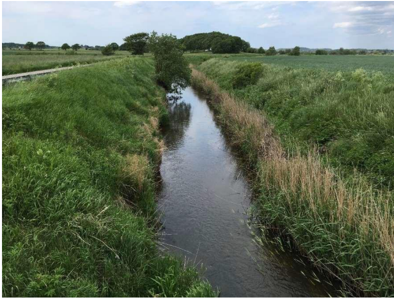
Bild: Himleån huvudfåra, rätad för att markavvattna jordbruksmark. Foto: R. Kaspersson.
