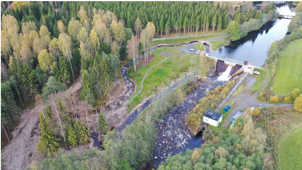
Figur 9. Faunapassage Rällsälv. Vy från nedströms sida av kraftverket. Utskovsdammen, intag och tilloppstub, maskinstation och kraftstationens utlopp syns i bilden. Bilden visar även hur faunapassagen mynnar i naturfåran, som längre ned mynnar precis invid kraftstationens utlopp. Detta bedöms leda till en god "anlockningseffekt" för uppvandrande fisk.
