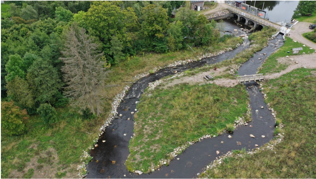
Figur 12. Drönarbild över den färdiga passagen vid Östtuna. Dammen/kraftverket som passagen passerar syns längst upp till höger i bild. På bilden ses även hur arbetet med platsen som besöksmål planerats och genomförts. En spång över passagen är byggd, ett picknickbord har ställts ut, en grillplats finns och en informationsskylt är på plats.
