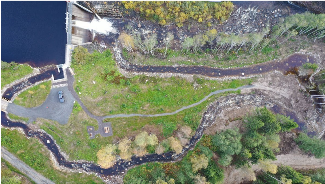
Figur 8. Drönbild över den färdiga passagen vid Rällsälv. Den relativt höga dammen syns längst upp till vänster i bild. Bilden illustrerar att passagen utformats med variabel lutning, vattenhastighet och bredd, i syfte att efterlikna ett naturligt vattendrag.
