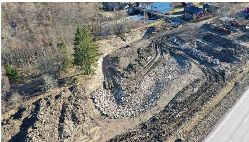
Figur 11. Pågående schakt och återfyllning av Östtunas faunapassage.
