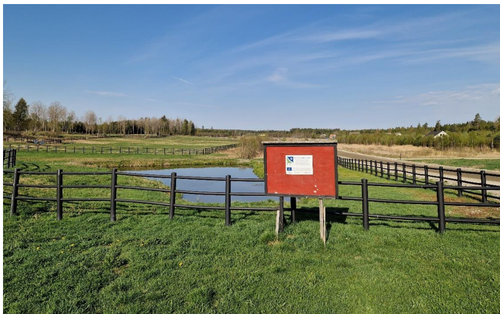
Figur 1 Sedimentationsdamm längs med rakbanan, tar upp dagvatten från ett stort hagamråde.
