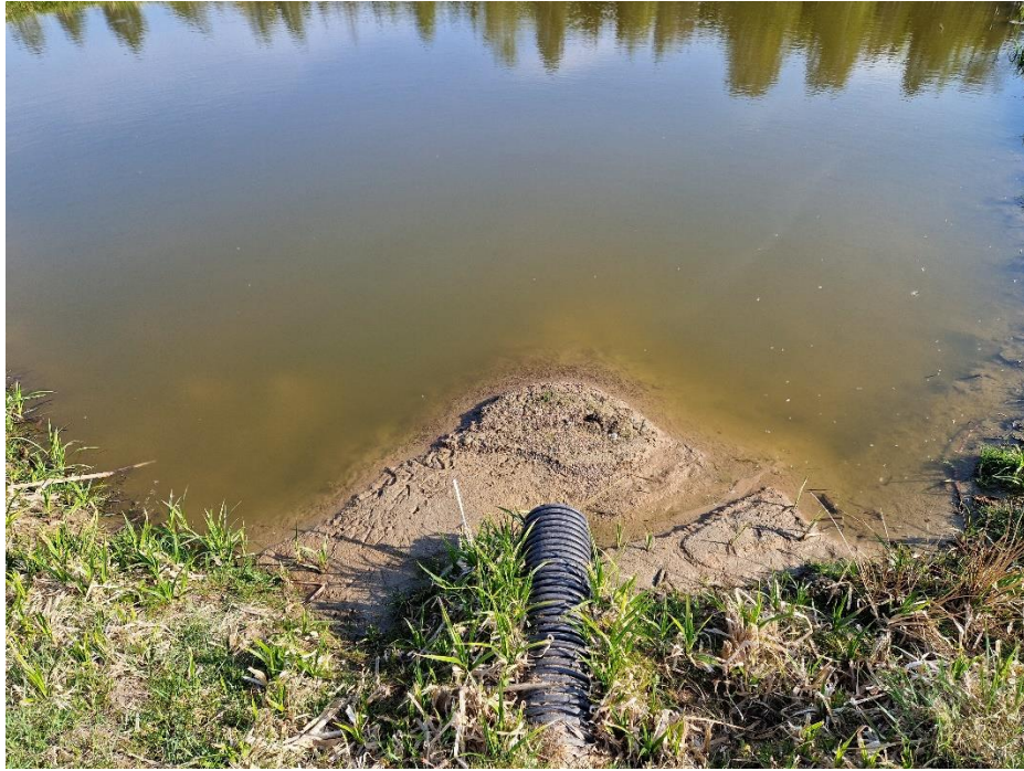
Figur 4 Exempel på erosion där sandpartiklar har spolats in i dammen, rensning krävs.
