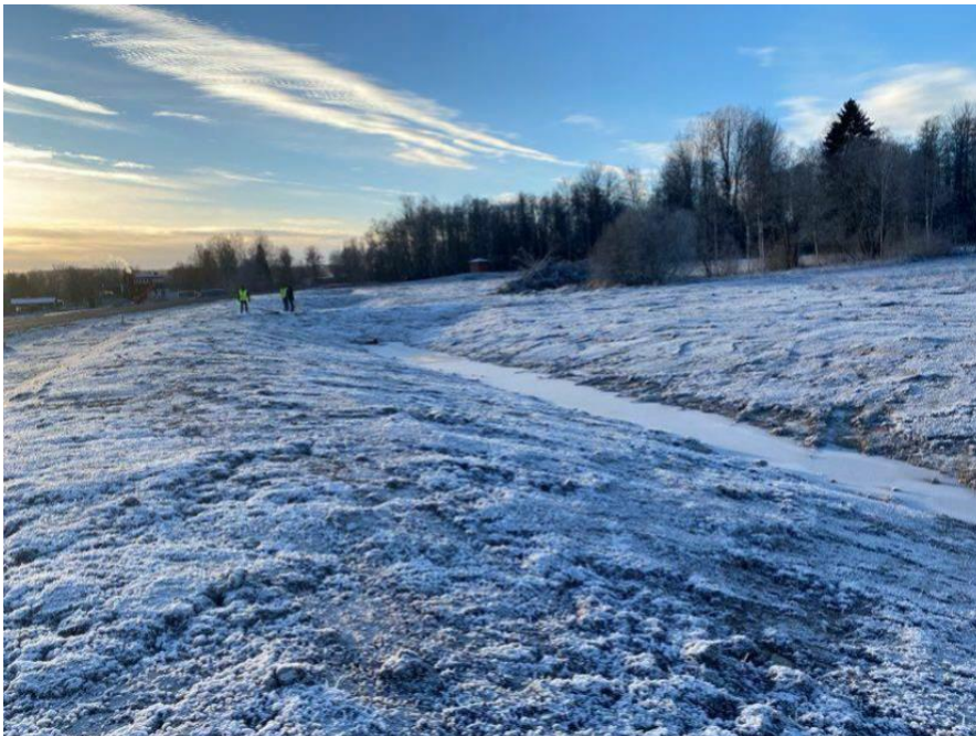
Figur 21. Uppsamlingsdamm från översilningsyta
