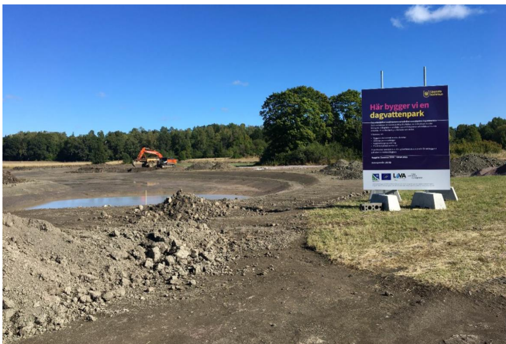
Figur 3. Byggskylt under anläggningsskedet.
