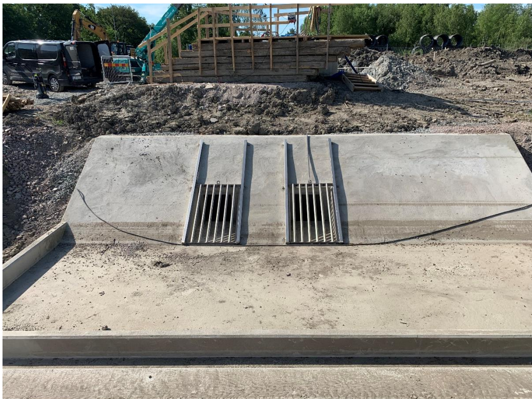
Figur 8. Intagsrännan i förgrunden och i bakgrunden pågår arbete med pumpstationen. Foto: Gustav Myhrman.
