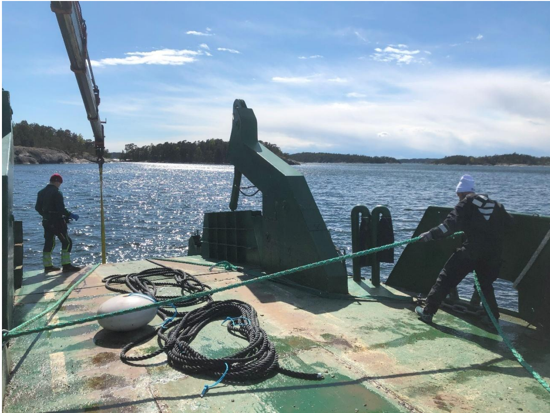
Figur 16. Iläggning av betongankare och fastsättning av ankarlinor vid etablering av nya enheter i Jungfrufjärden.
