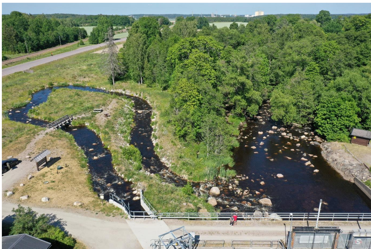
Figur 5 Omlöpet och spillfåran vid Östtuna kraftstation (Norconsult 2023-06-15)
