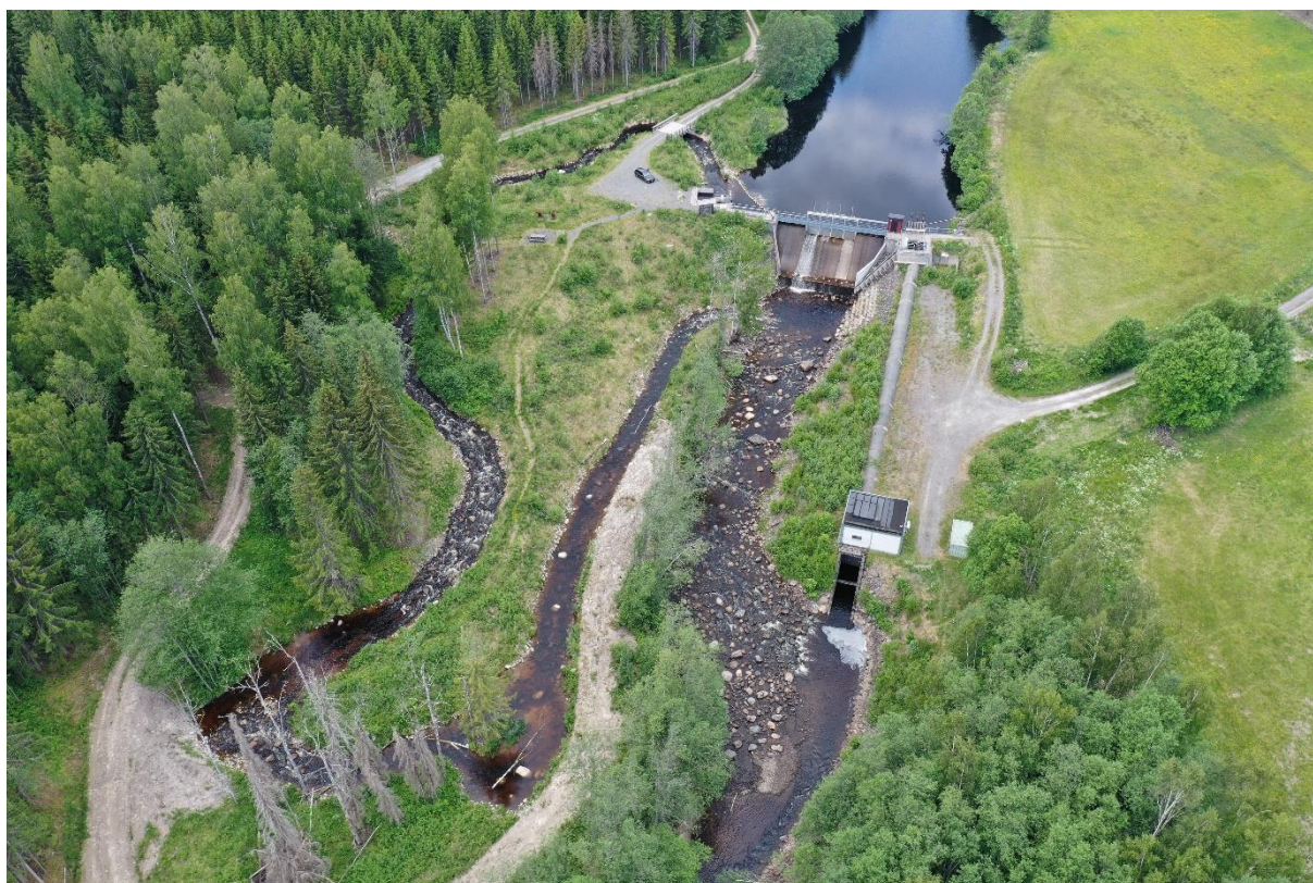
Figur 8 Drönbild på strömsträckan nedan kraftverket och omlöpet i Rällsälv. Norconsult 2023-06-14
