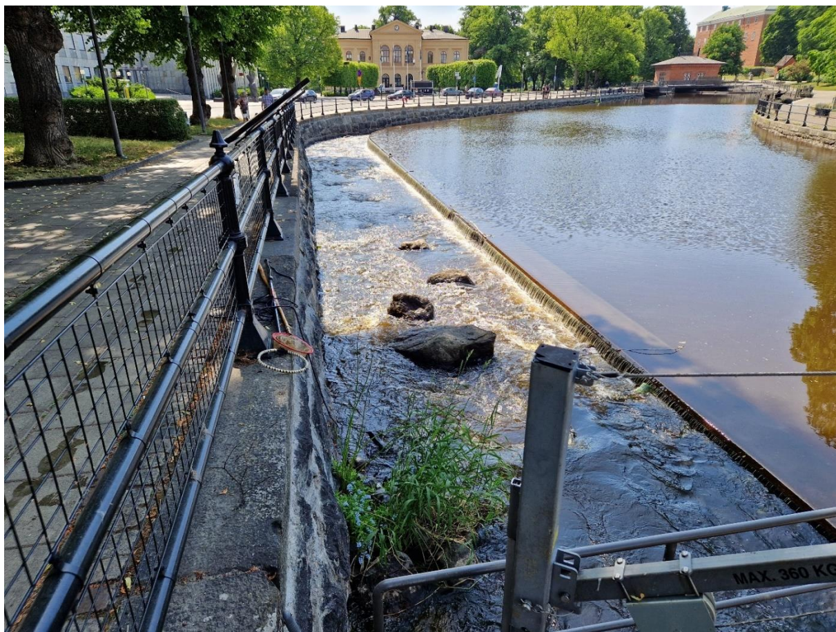
Figur 3 Inlöpet i Svartån- Västerås. Sett uppströms ifrån ner mot Turbinbron (Norconsult 2023-06-16)
